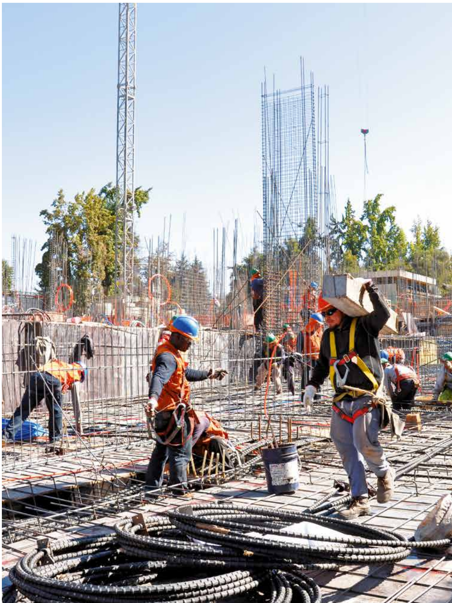
CONSTRUCCIÓN PROYECTO "VERDECE", LO BARNECHEA, SANTIAGO
