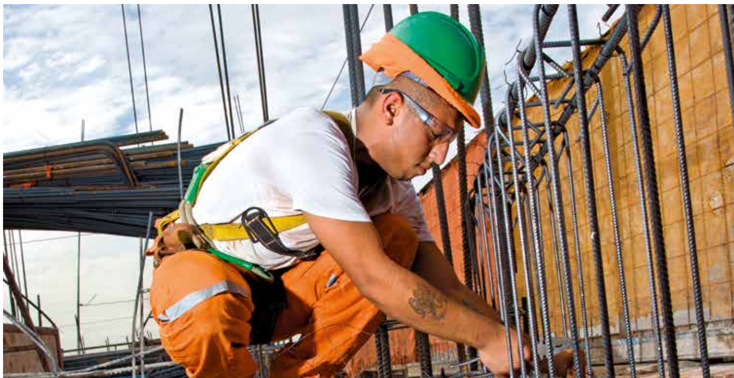
CONSTRUCCIÓN PROYECTO "CENTRO ALAMEDA", ESTACIÓN CENTRAL, SANTIAGO
